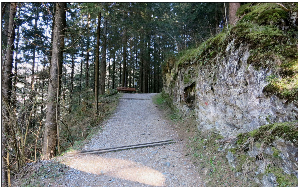
Abb. 3: Steilstehende Schieferungsflächen bilden die Felswände im stabilen Westabschnitt
