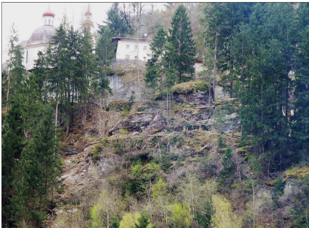
Abb. 2: Blick auf das in Bewegung befindliche Gelände talseitig der Kirche Maria Rast
