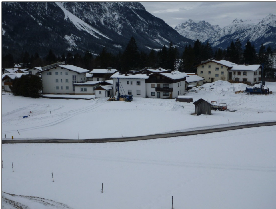
Abb.2: Übersicht über die Bohrungen im Ortsgebiet von Weißenbach im Zuge der Untergrunderkundungen. Jene Bohrung, bei der es zu einem Gasaustritt kam, befindet sich in der rechten Bildhälfte neben dem Holzstadel.
